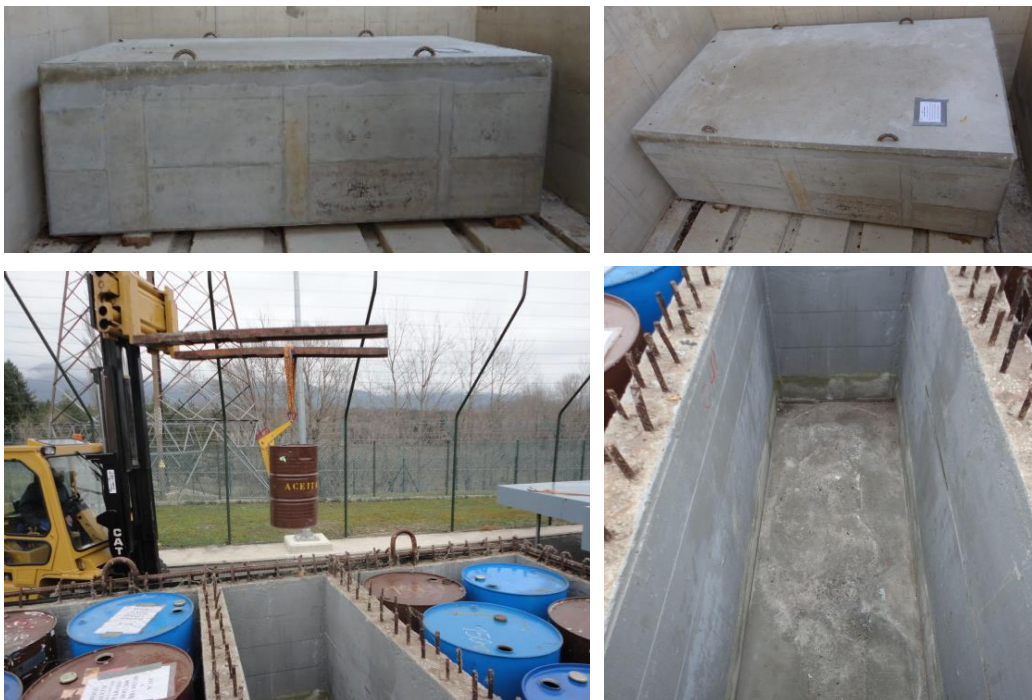
Figura 13.1. Imagen del cofre sellado de hormigón de C. N. Santa María de Garoña durante su acondicionamiento en los años 80.
