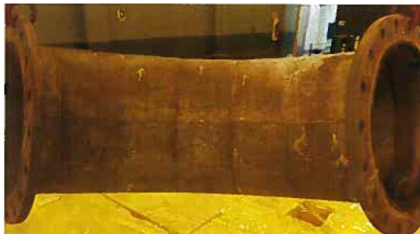
Figura 7.4. Imagen del conducto de ventilación.
